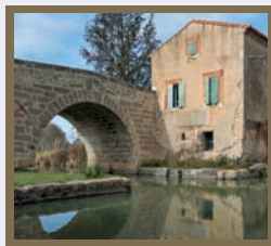
Pont de Pigasse, Quarante
