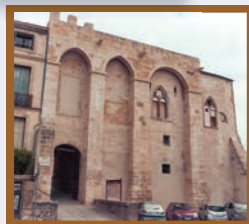
Château des archevêques, Capestang
