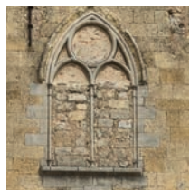
Château des archevêques, Capestang
